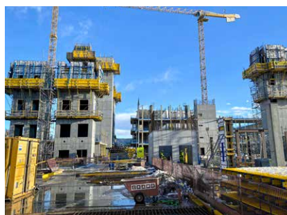
Überwachung der Betonfrühfestigkeitsentwicklung
