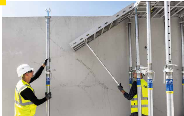
DokaXlight beim Hochschwenken
