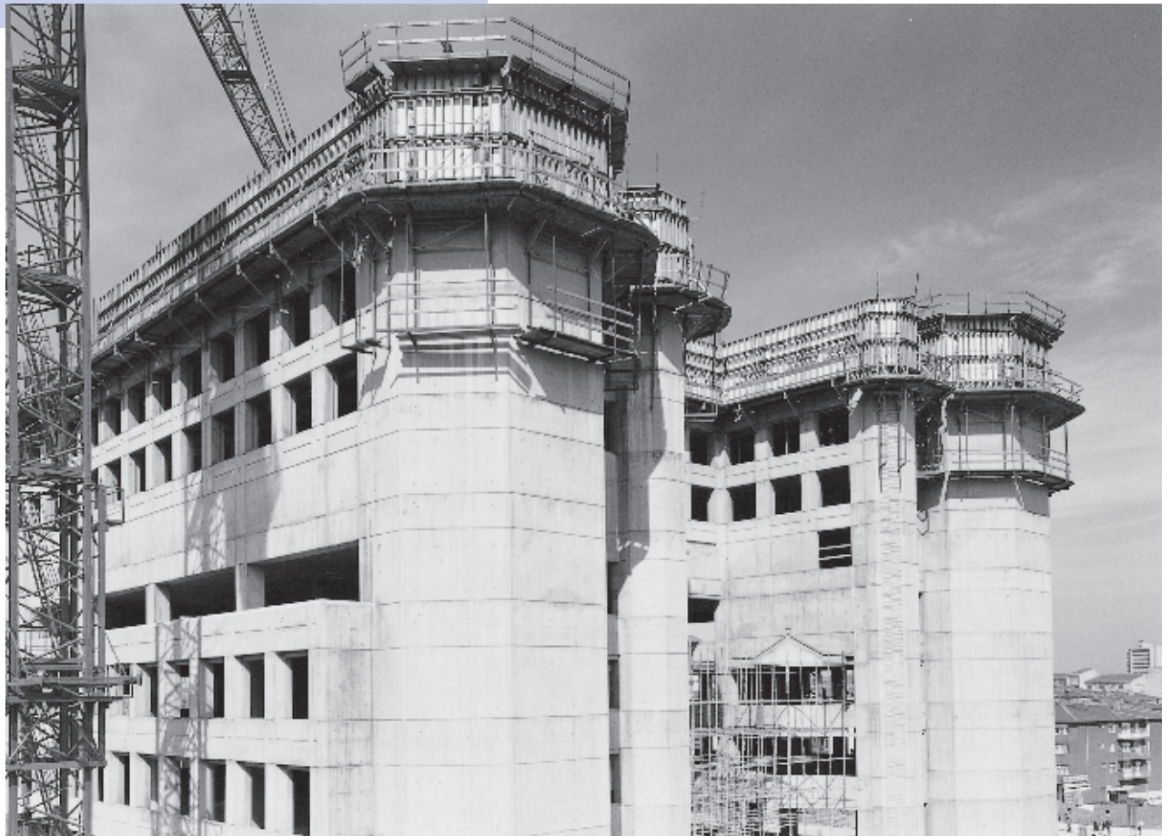
Edifício bancário, Ancara
