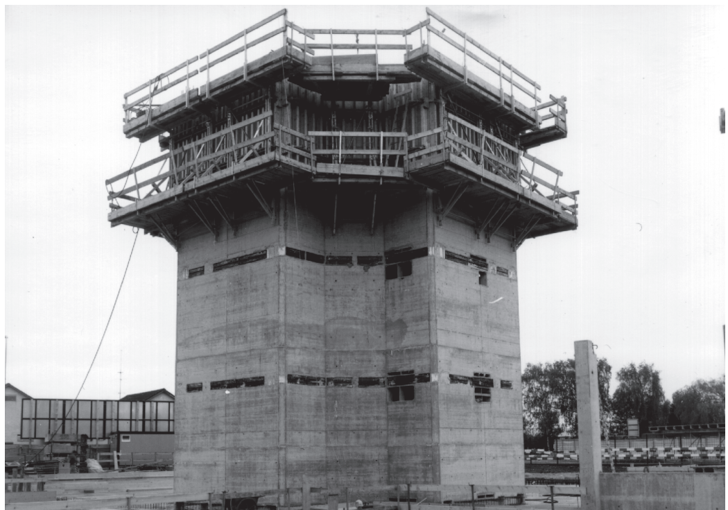
Edifício "Im Cher", Opfikon
