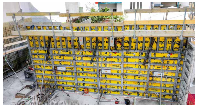
Testbaustelle Soley in Wien, Österreich
