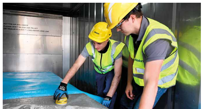
Concremote als Teil der Prototypenentwicklung der Intelligent Beheizbaren Schalung
