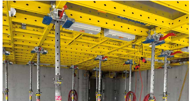
Testbaustelle in Trondheim, Norwegen
