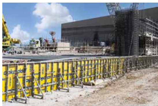
Det trengs heller ikke ekstra avstivning på lage rette vegger.
