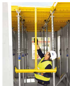
Ergonomisks darbs ar DokaXbot Lift un DokaXdek I-veida karkasu* (*demonstrācijas versija).
