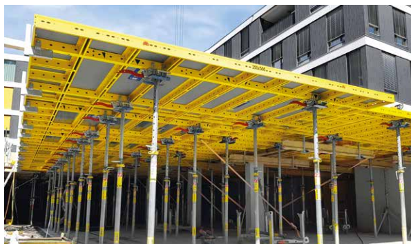
DokaXdek galda izmantošana ARGE Garnmarkt, Götzis, Austrija
