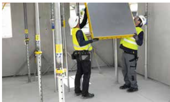
Varno sestavljanje DokaXdek-panelni opaž plošč s tal
