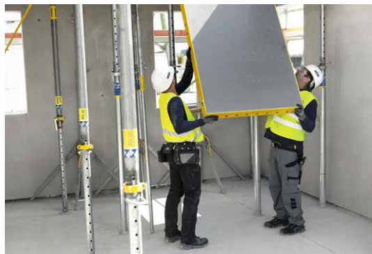
DokaXdek panelové stropné debnenie je ľahký a flexibilný panelový systém. Montáž vyžaduje 2 osoby.
