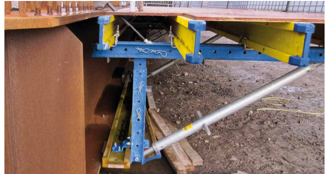
Die flexible Kragarmschalung wird mittels wiedergewinnbarer Schräganker am Brückentragwerk befestigt.
