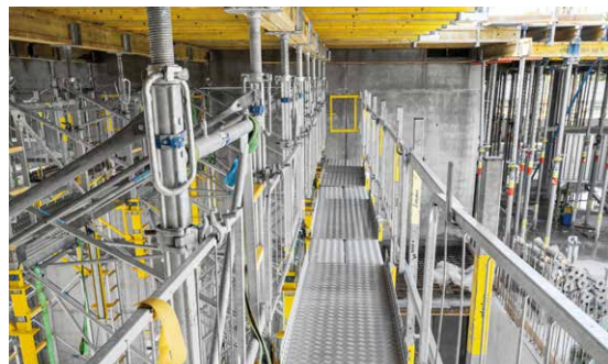
Die Montageplattform ermöglicht eine ergonomische und effiziente Montage der Oberkonstruktion ohne Kompromisse bei der Sicherheit oder der Flexibilität.
