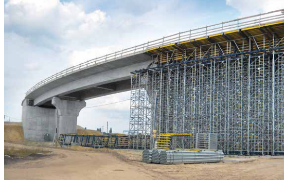
Die robusten Staxo 100 Stahlrahmen stellen ihre hohe Tragfähigkeit im freistehendem Einsatz unter Beweis.
