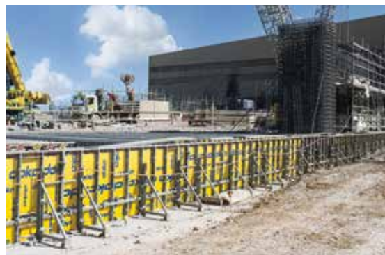
Aanvullende uitstijvingen zijn ook bij lange uitlijningen niet vereist.
