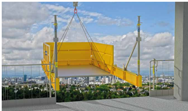
Fiksavimas tarp plokščių leidžia lengvai pastatyti krovimo platformą ties statinio kraštu.
