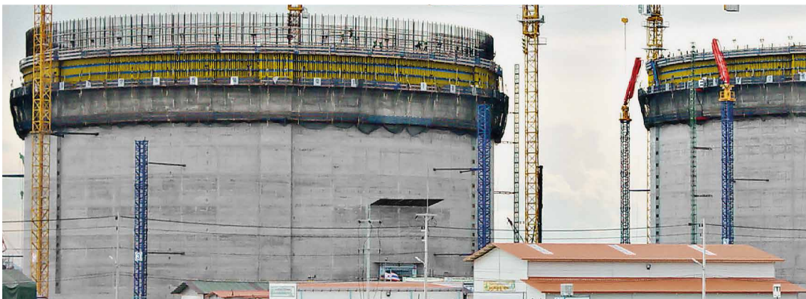
Kletterschalung 150F im Einsatz bei zwei großen LNG Tanks in Thailand.
