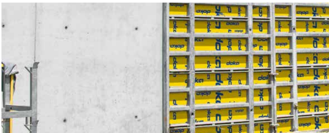
Le parement béton du Framax Xlife se distingue par une surface plane et propre avec un calepinage aligné des joints, sans empreintes dues à la fixation des panneaux
