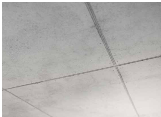
Lijep rezultat betoniranja
