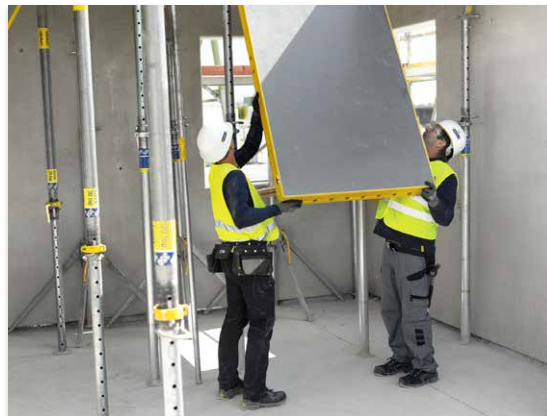
Sigurna montaža DokaXdek panelne stropne oplata s tla
