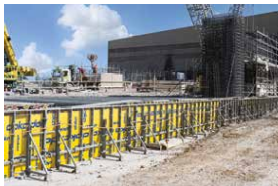
Még számos elem illesztése során sincsen szükség kiegészítő merevítésre.
