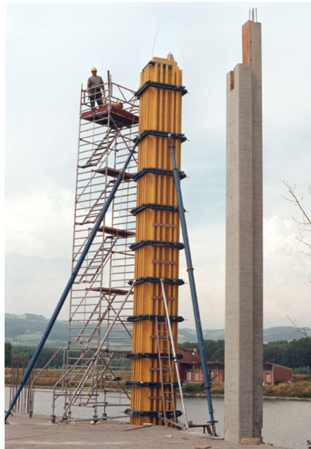
Baustelle: SBL-Halle, Linz
