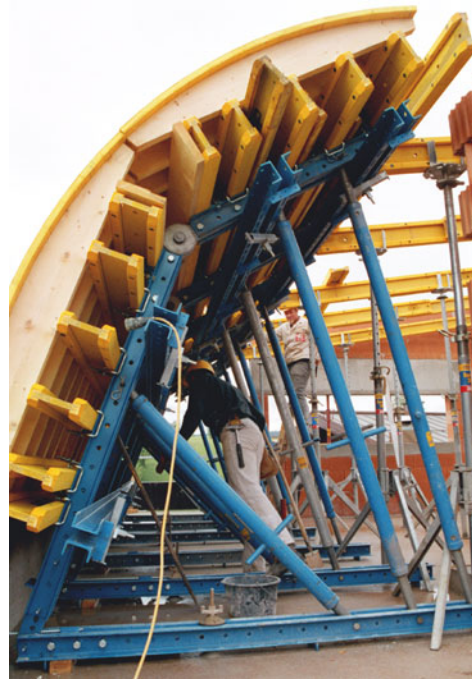
Baustelle: Neubau Candido, Saalfelden
