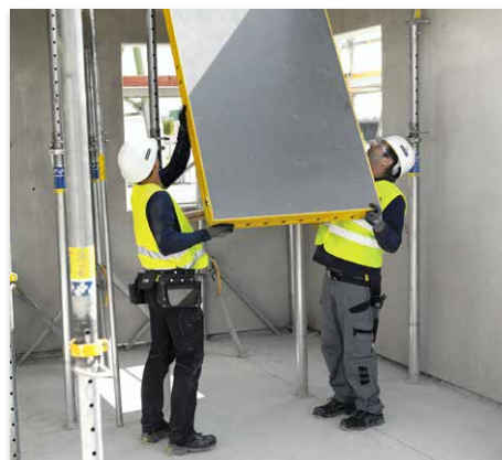
Bezpieczny montaż panelowego deskowania stropowego DokaXdek z podłoża
