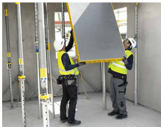
Bezpečná montáž panelového stropního bednění DokaXdek ze země
