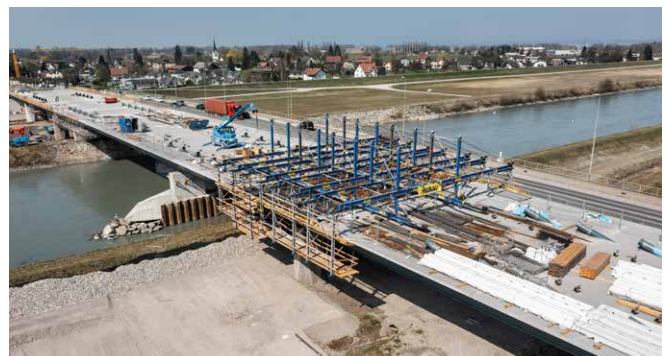
Rheinbrücke Hard-Fußach, Österreich. Maßgeschneiderter Verbundschalwagen mit zwei Längsfachwerken und zwei zusätzlichen Reihen Pendelstützen ermöglicht die Herstellung dieses außergewöhnlich breiten und asymmetrischen Querschnitts.
