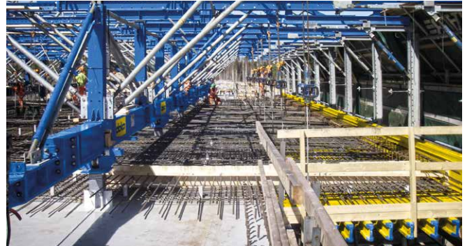
Durch den Systemträger NG lässt sich der Verbundschalwagen noch flexibler an die Bauwerksgeometrie anpassen.
