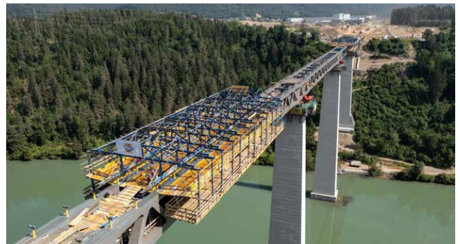
Jauntalbrücke, Österreich. Hohe Arbeitssicherheit in 96 m Höhe sowie individuelle Anpassung der Schalung an das Stahltragwerk sorgen für reibungslosen Baufortschritt.
