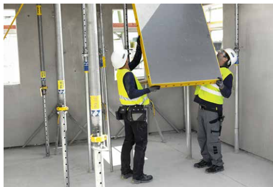
De DokaXdek paneel-vloerbekisting is een licht en flexibel tweemans-systeem.
