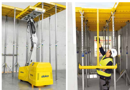
Ergonomisch werken met DokaXbot* en DokaXdek I kader* (*demoversies).
