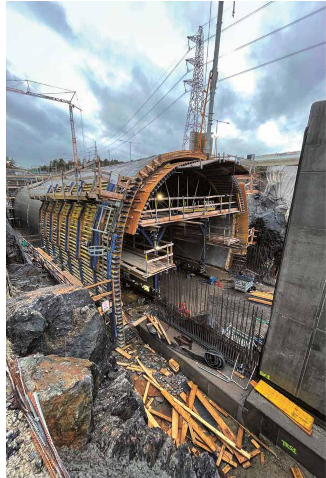
1 Für die Doka-Niederlassung in Schweden war das Projekt Skärholmen Tunnel eine Premiere: Entwicklung einer Schalungslösung für einen runden, in offener Bauweise hergestellten Tunnel.
