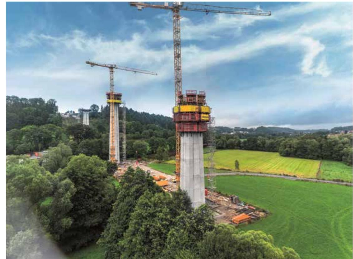
2 Die Talbrücke wird von insgesamt sechs Pfeilern gestützt, die zum Teil eine Höhe von 66 m erreichen.
