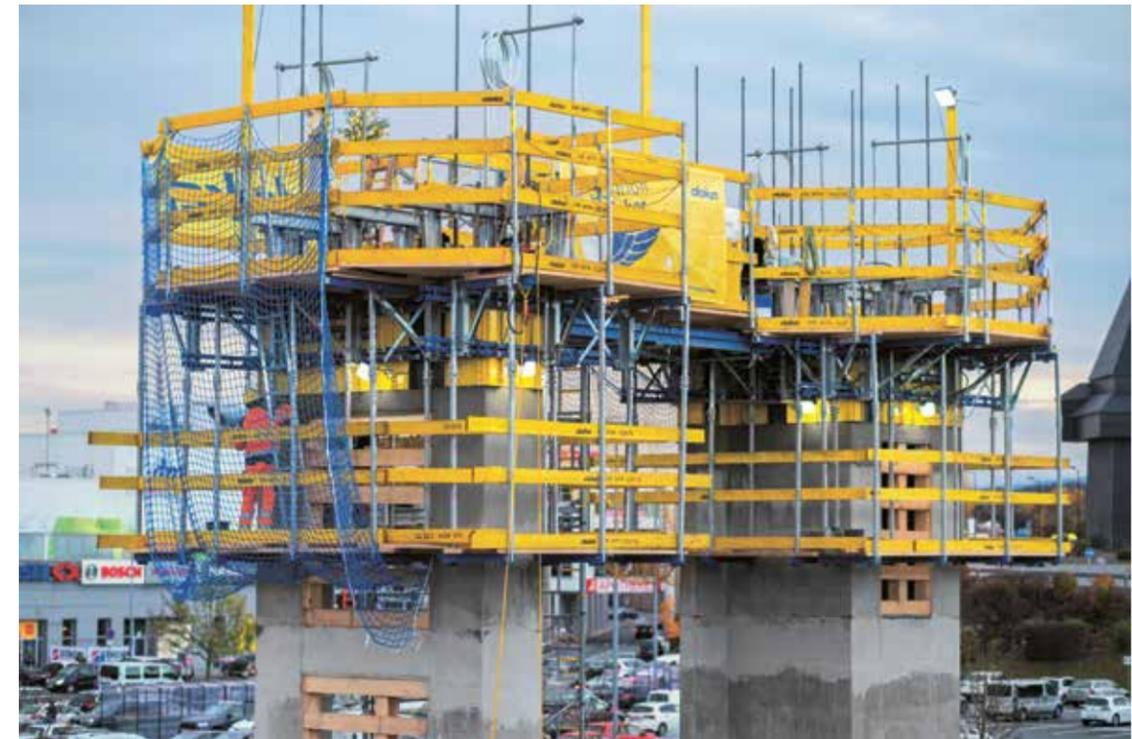
2 Die Gleitbaumethode erlaubt ein Betonieren 24/7, wodurch hohe Bauprojekte schnell und wirtschaftlich errichtet werden können.
