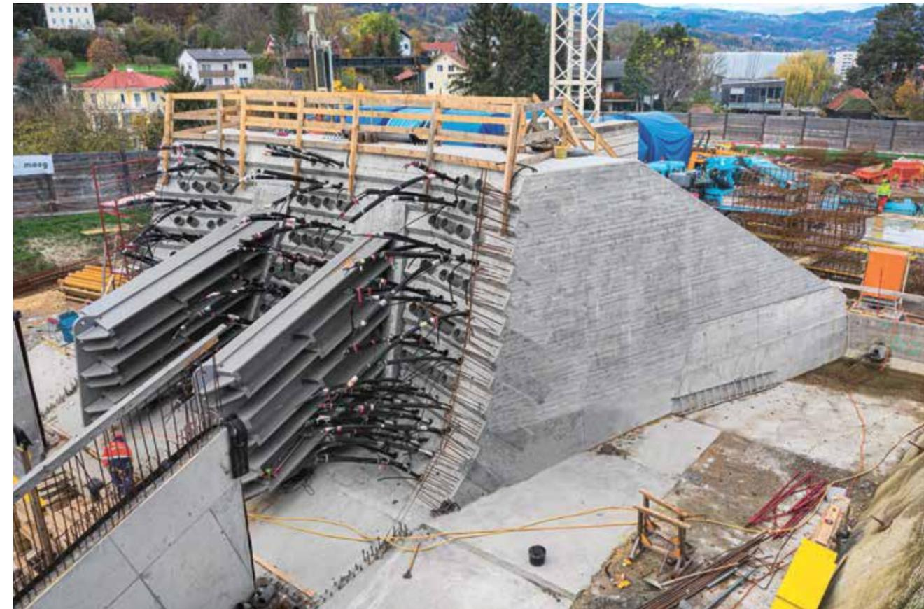
1, 2 Für die Herstellung des komplexen, großvolumigen Baukörpers lieferte Doka ein cleveres Paket aus Hard- und Software: die maßgeschneiderte Schalung für den Ankerblock und das Betonmonitoring Concremote zur permanenten Aussteuerung der Betonqualität beim Aushärten.
