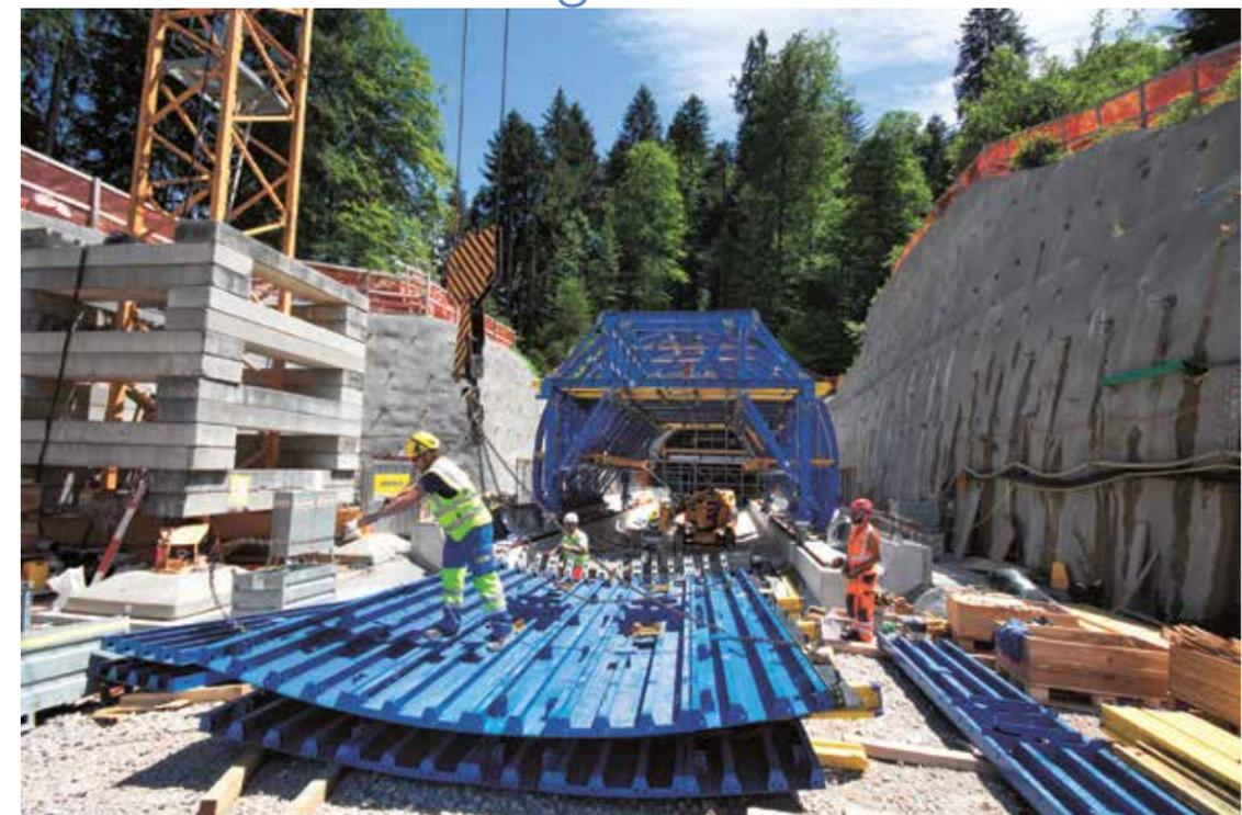
2 Großer Montagefortschritt auf der Baustelle dank vormontierter und einsatzfertiger Stahlkomponenten.
