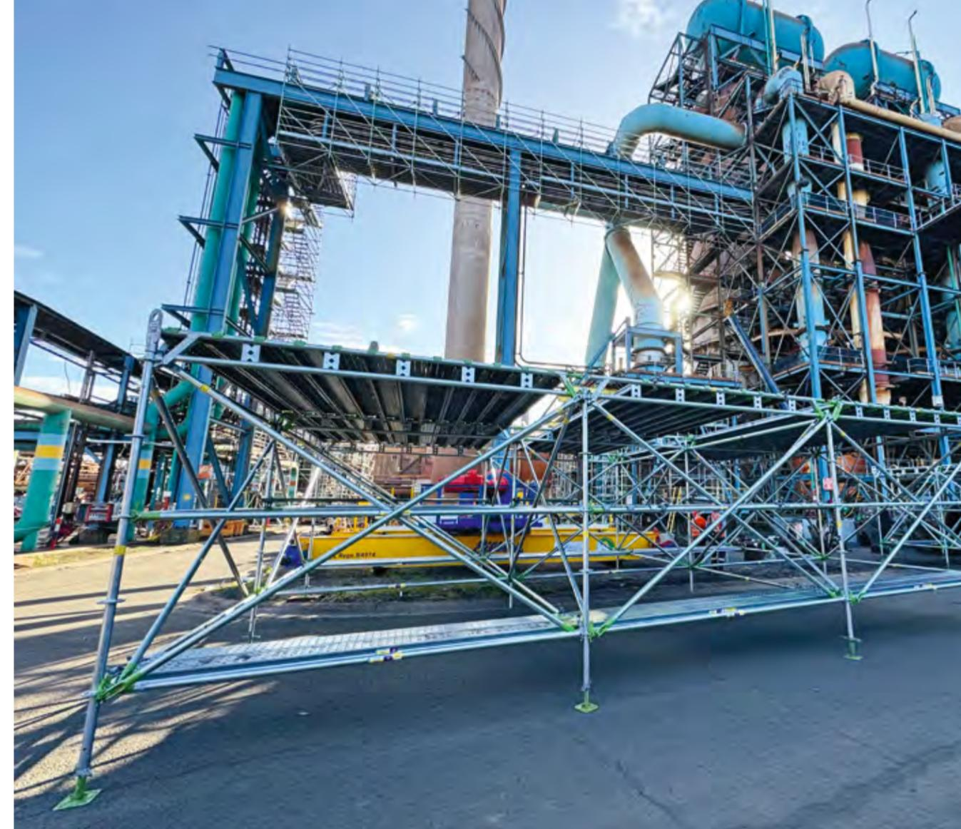
BlueScope betreibt das Stahlwerk in Port Kembla, New South Wales (Australien). Das Industrieriegerüst Ringlock kommt derzeit für Umweltsanierungsarbeiten zum Einsatz.
