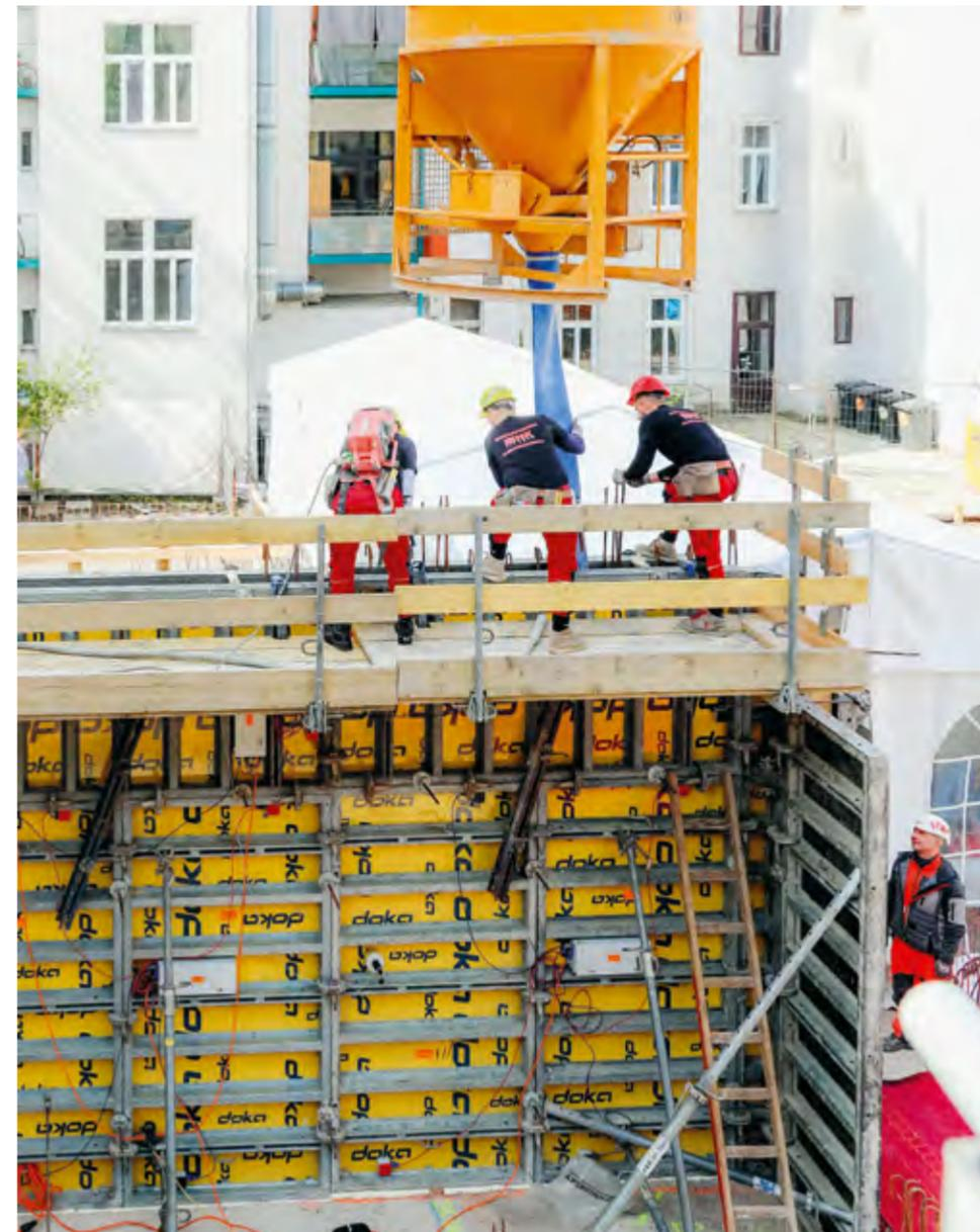
Vorzeigeprojekt in Wien: erstmalige Verwendung von CO<sub>2</sub>-reduziertem Beton (RCC) bei einem Wohnprojekt von STRABAG Real Estate. Für die Errichtung der Wände kommt im Keller und im Erdgeschoss der Doka-Prototyp zum Einsatz.
