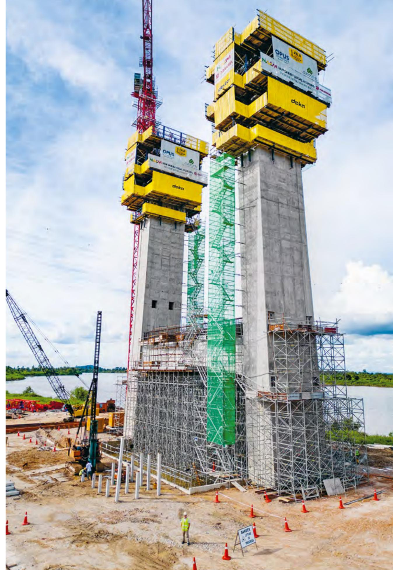
Das Modulgerüst Ringlock und die Selbstkletterschalung SKE 100 plus im Einsatz bei der Entstehung des westlichen Pylons.
