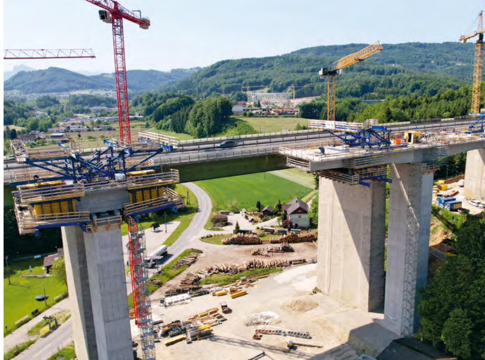
Die mit 50 m höchste Brücke der Westautobahn ist in die Jahre gekommen und wird bis Ende 2025 neu gebaut. Um den Verkehr nicht zu behindern, wurde im ersten Schritt parallel zur bestehenden Brücke eine neue (temporäre) Brücke errichtet.
