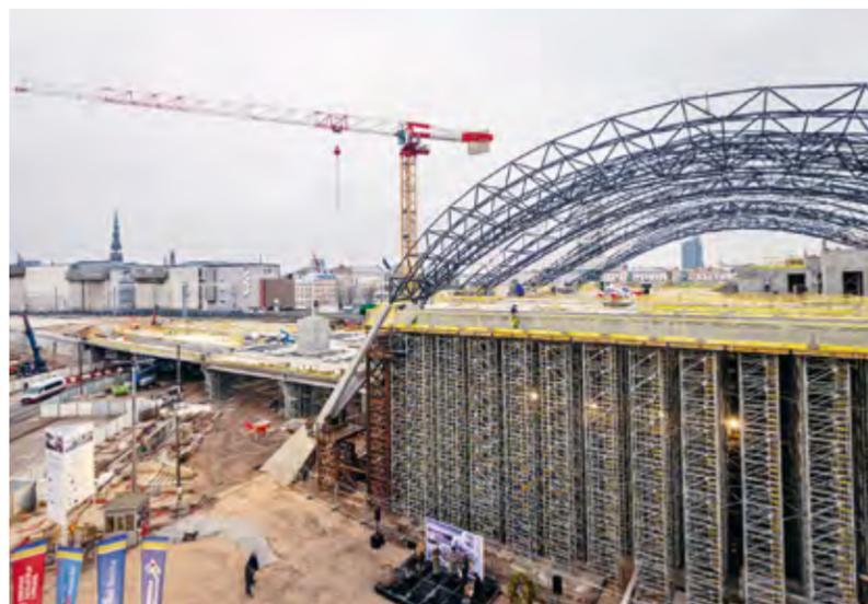
Für die Errichtung der Brücke von und zur Bahnstation kamen Doka Staxo und Ringlock zum Einsatz, ebenso wie das Betonmonitoringsystem Concremote.
