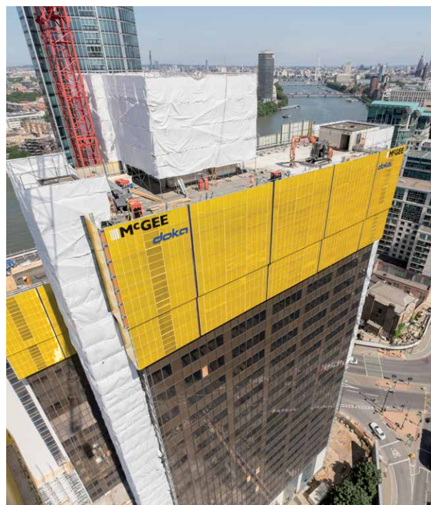
No. 1 Nine Elms, London, UK | 89 m: Automatisk nedklatring med støjdæmpende indkapsling til kontrolleret nedrivningsarbejde
