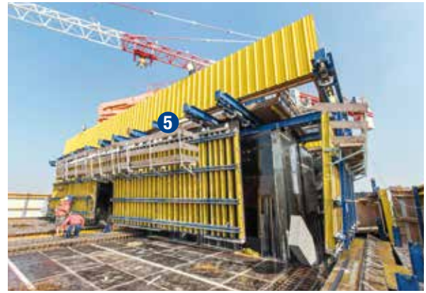
▲ SKE100 plus im Einsatz beim Projekt Torre Isozaki in Mailand. Für die Wandelemente wurden Träger- und Rahmenschalungen miteinander kombiniert.
