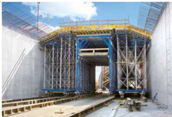
▲ Traggerüst Staxo 100 mit Tunnelschalungssystem SL-1 kombiniert
