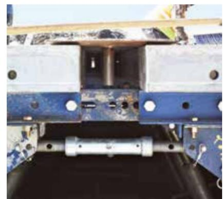
▲ **Frühausschalen** durch Abhängen des Fugenbleches
