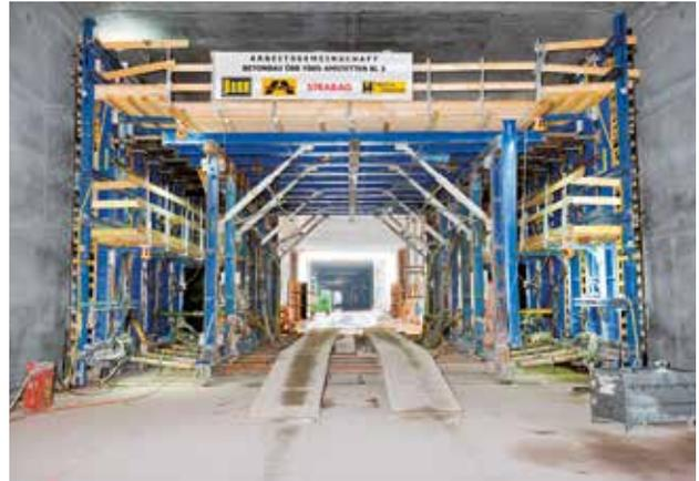
Je nach Taktplanung kommen Abstützböcke oder auch durchgestützte Schalwagen für die Vorsatzschale zum Einsatz. Bei der durchgestützten Variante muss die Beschickung und Logistik auf der Baustelle ermöglicht werden.
