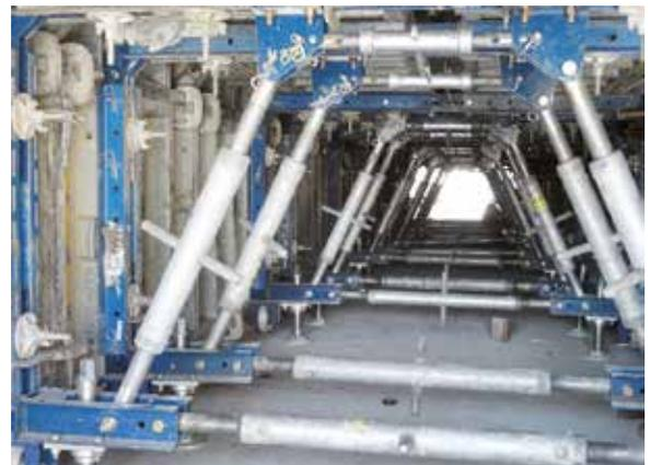
▲ Durchgangsmöglichkeit auch bei kleinsten Querschnitten
