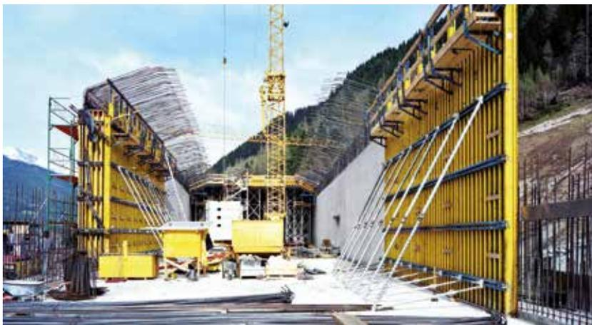
Bei der aufgelösten Bauweise können die Wände mit Träger- bzw. Rahmenschalungen oder Abstützböcken hergestellt werden. Für die Decke werden oftmals Traggerüste in Kombination mit Tunnelsystemen verwendet. Je nach Länge, Anzahl der Einsätze und baustellen-spezifischen Einflüssen wird das richtige System inklusive Dienstleistungen in einem Gesamtkonzept von den Experten von Doka erarbeitet.
