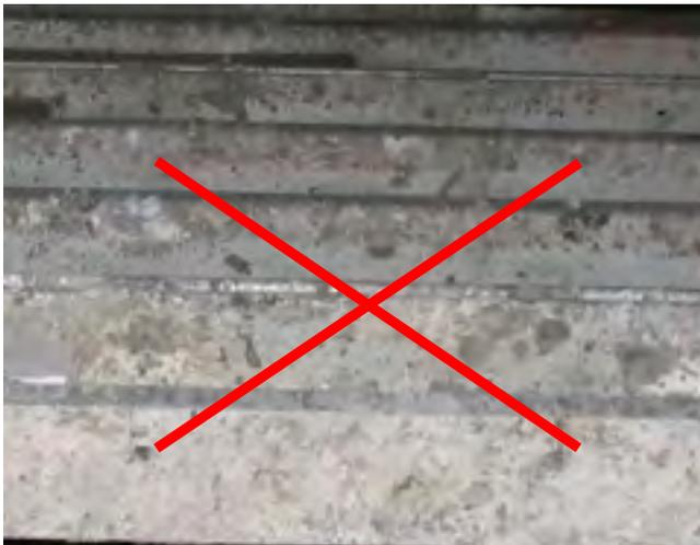
Sporcizia troppo marcata sul lato posteriore del telaio dell'elemento.
