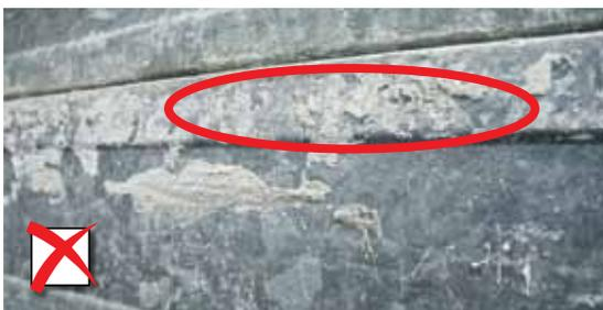
**La surface de contact ne doit pas contenir de résidus de béton.**
