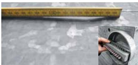
**Des déformations sur le profilé jusqu'à 5 mm de profondeur et d'une longueur max. de 80 mm sont acceptées.**
