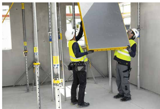
DokaXdek-luckan är ett lätt och flexibelt lucksystem för 2 personer.
