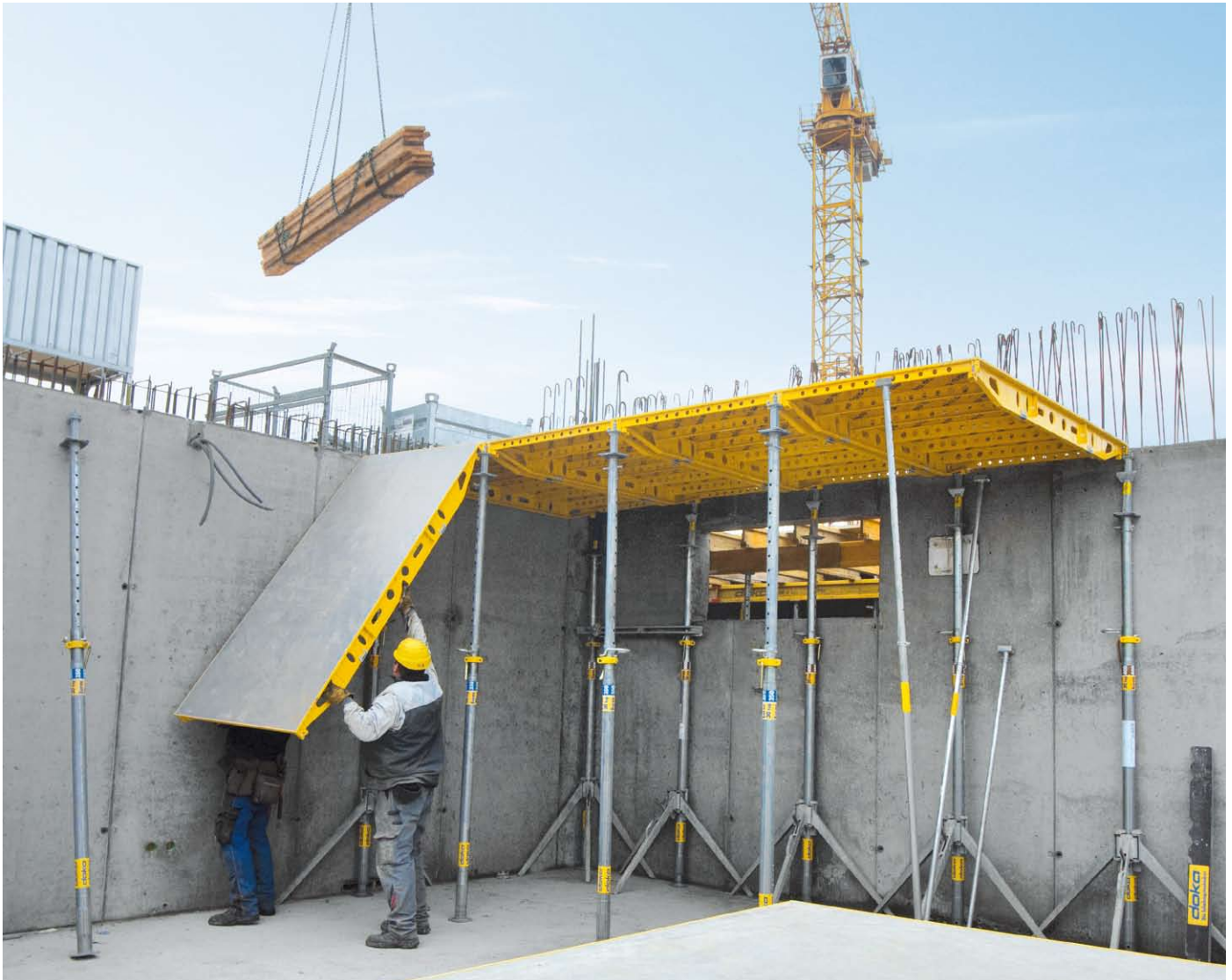
Einschalen vom Boden aus per Hand. Die wertvolle Krankkapazität bleibt frei und kann für andere Arbeiten zur Beschleunigung des Bauablaufs eingesetzt werden.
