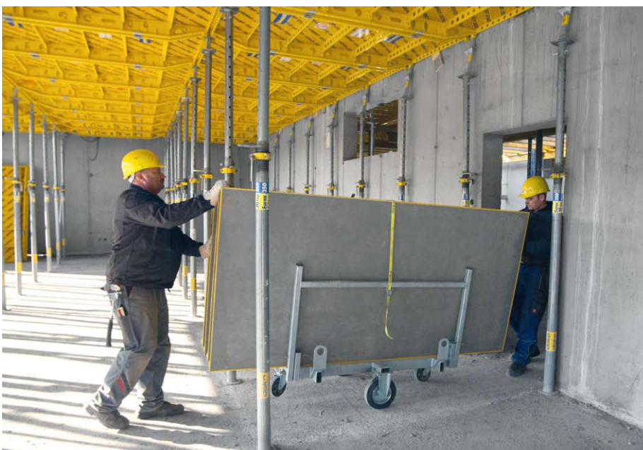
Der DekDrive passt durch jede Tür. Schnelles und ergonomisches Umsetzen ist auch bei Schottenbauweise gewährleistet.
