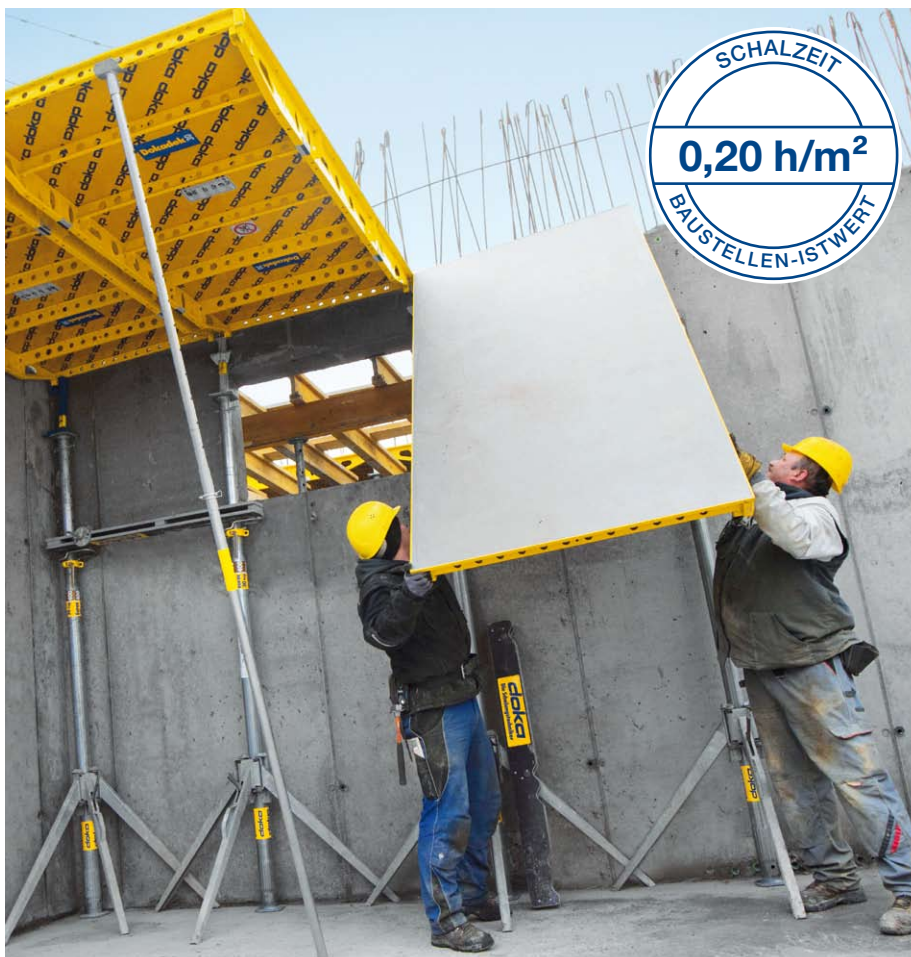
Mit den rechteckigen Elementen sind auch hohe Decken leicht schalbar.
