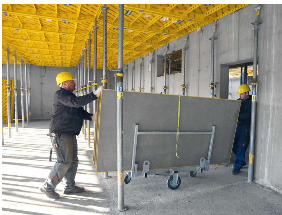
Il carrello DekDrive passa attraverso ogni porta: Traslazione rapida ed ergonomica anche nelle strutture a paratie.
