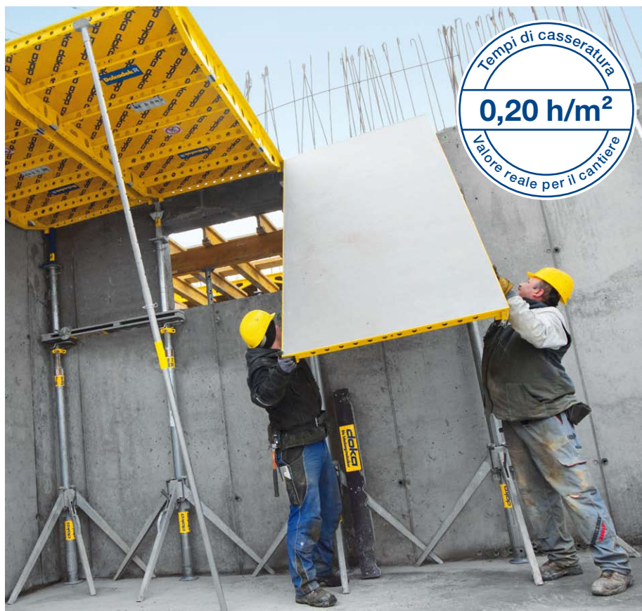
Con gli elementi rettangolari è possibile cassetare facilmente anche solai alti.
