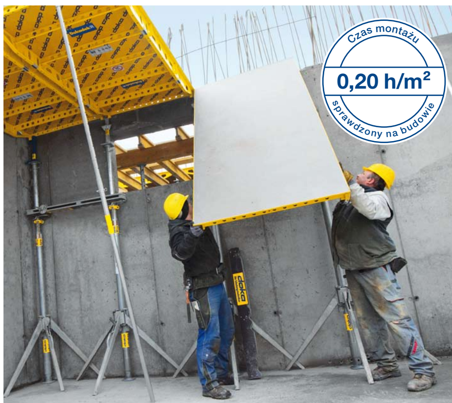
Prostokątne elementy ułatwiają deskowanie wysokich stropów.
