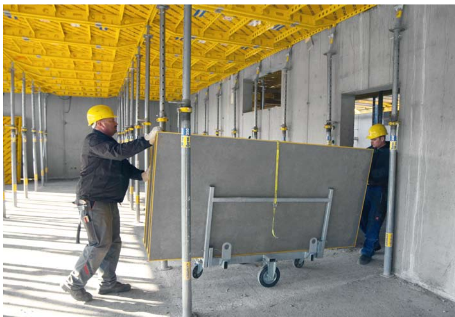
Wózek DekDrive przejedzie przez każde drzwi: Szybkie i ergonomiczne przestawianie deskowania nawet przy ograniczonej ilości miejsca.
