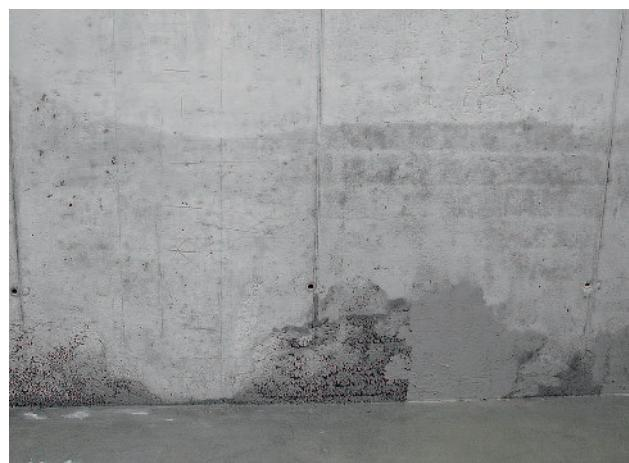
Вид бетона без уплотнительного шнура
