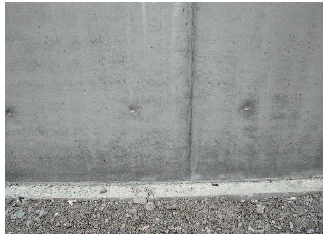
Вид бетона при использовании уплотнительного шнура
