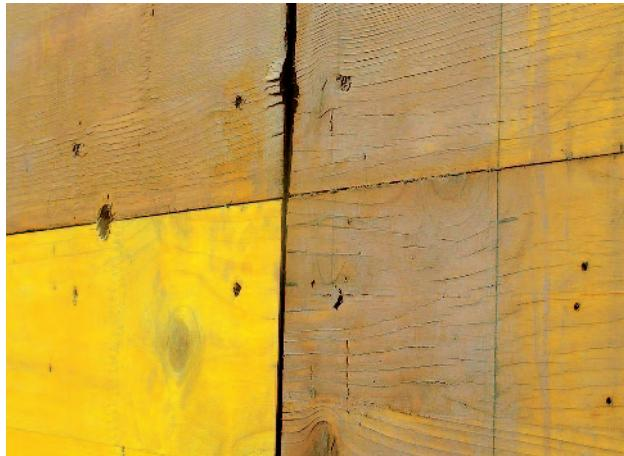
Пример: смещение в стыке элементов
