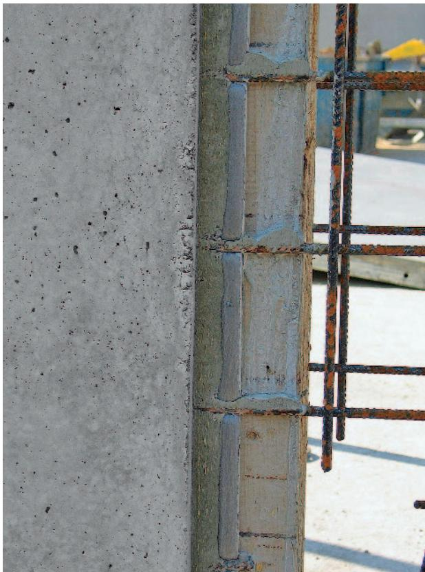
Торцевая опалубка с уплотнительным шнуром
