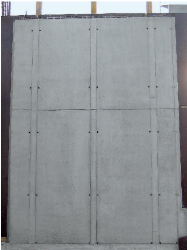
Одинаковый вид палубы (рамная опалубка - пригнанный брус с накладкой из палубы)
