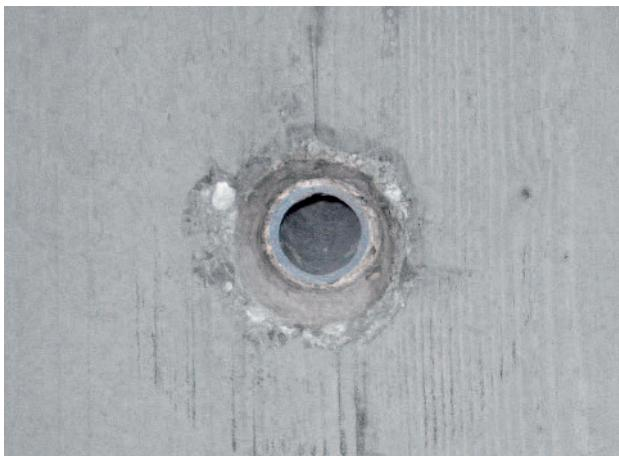
Выламывание бетона в месте анкерного крепления
