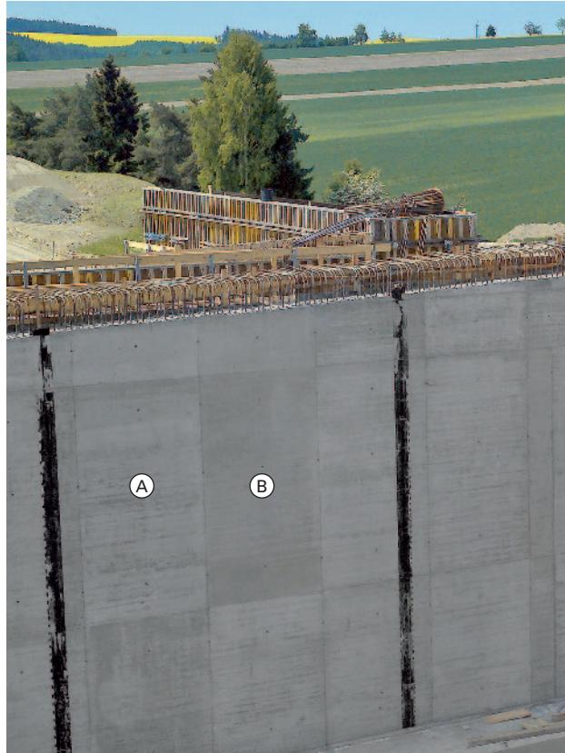
**A** Нижний элемент в штабеле (низкие абсорбционные свойства палубы)
