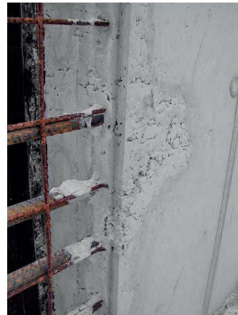
Пример: торцевая опалубка без уплотнения
