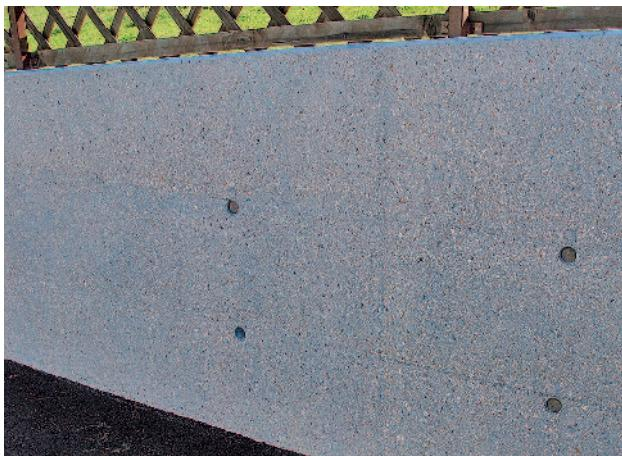
Пример: пигментированный бетон синей расцветки, обработанный молотком с насечкой (бучардой)
