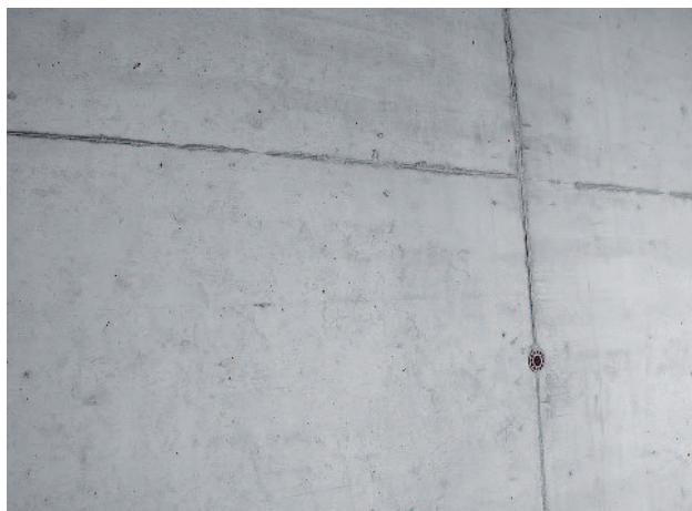
Картина бетона при смещении в стыке элементов
