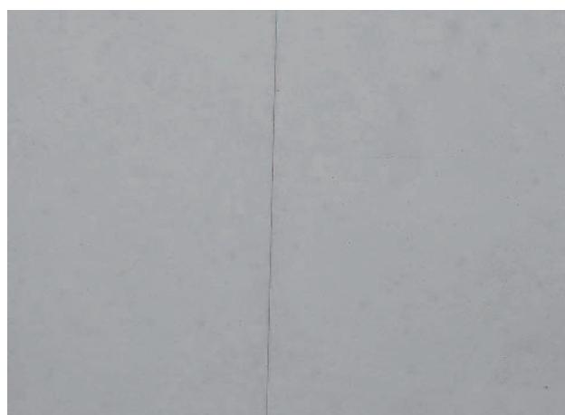
Картина бетона в зоне герметизации стыка между плитами Dokaplex
