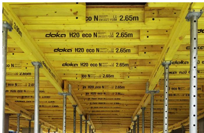
Le travi H20 eco utilizzate per la cassetta di solai con il sistema Dokaflex
