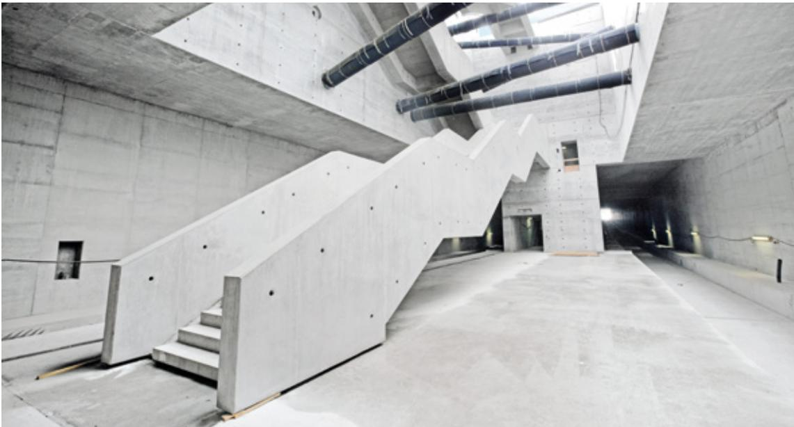
Doka-Optix begünstigt porenfreie Betonoberflächen und ermöglicht ein ausgezeichnetes Sichtbetonergebnis. City Tunnel Leipzig und Bahnhöfe, Deutschland
