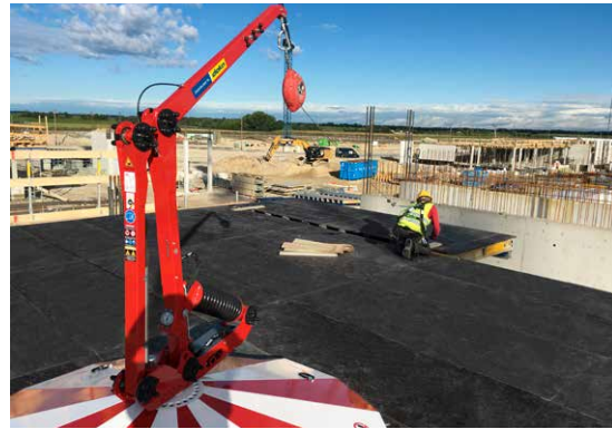
Der FreeFalcon sichert die Baustellenmannschaft in Situationen, wenn temporär unvermeidlich an Absturzkanten gearbeitet werden muss.
