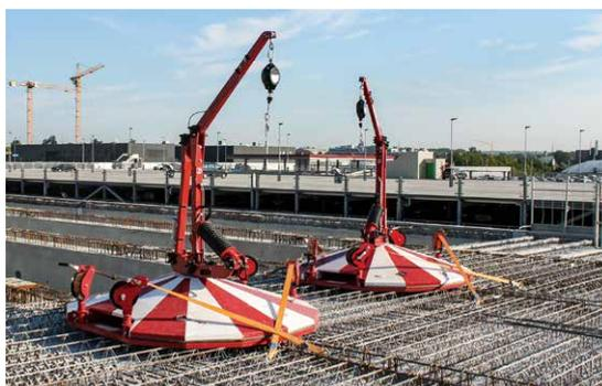
Le FreeFalcon PCC a été tout spécialement développé pour l'application avec des coffrages modulaires de dalles. Il sécurise les équipes travaillant dans la zone présentant un risque de chutes lors de la pose des coffrages modulaires de dalles.
