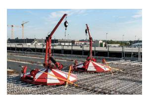
Le FreeFalcon PCC a été tout spécialement développé pour l'application avec des coffrages modulaires de dalles. Il sécurise les équipes travaillant dans la zone présentant un risque de chutes lors de la pose des coffrages modulaires de dalles.
