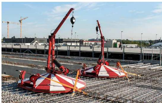
FreeFalcon PCC è stato sviluppato appositamente per essere posato sugli elementi per solai e protegge il lavoratore sul bordo di caduta durante il montaggio degli stessi.
