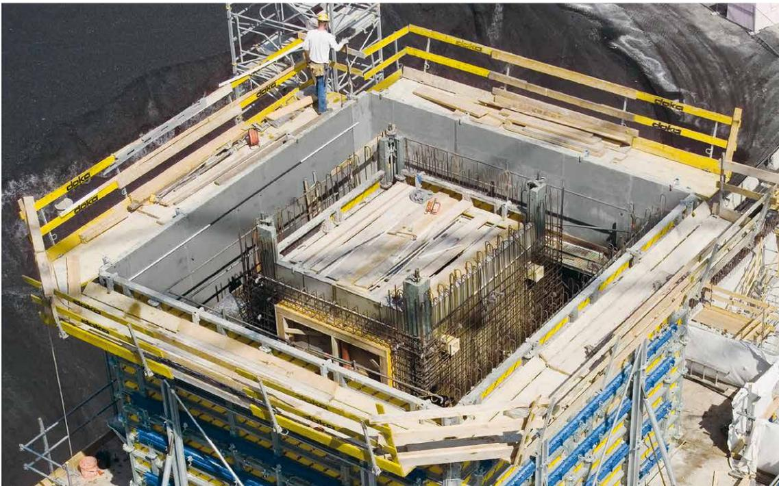
Schachtschalung zusammen mit Selbstkletterschalung Xclimb 60 und Rahmenschalung Framax Xlife im Einsatz beim Gas- und Dampfkraftwerk Timelkam, Österreich
