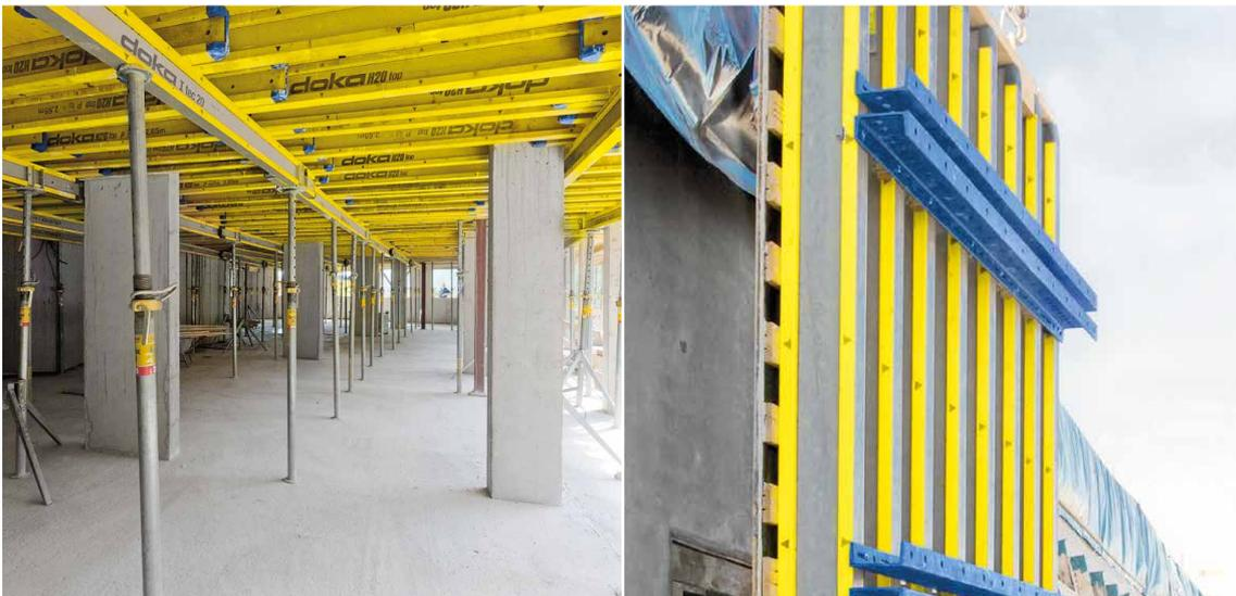
Durch die hohe Tragkraft des Verbundschalungsträgers I tec 20 werden weniger Systemteile benötigt. Das spart Material und beschleunigt den Bauablauf.
