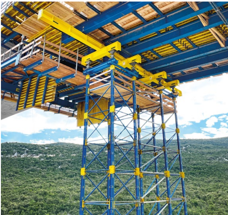
Dumanja Jaruga | Kroatien | Doka UniKit Lastturm 480kN, Joch- und Längsträger, Verlängerungen und Schwerlastjoche
