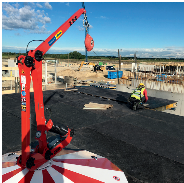
Il FreeFalcon protegge dalle cadute la squadra in cantiere quando deve necessariamente lavorare temporaneamente su bordi di caduta.
