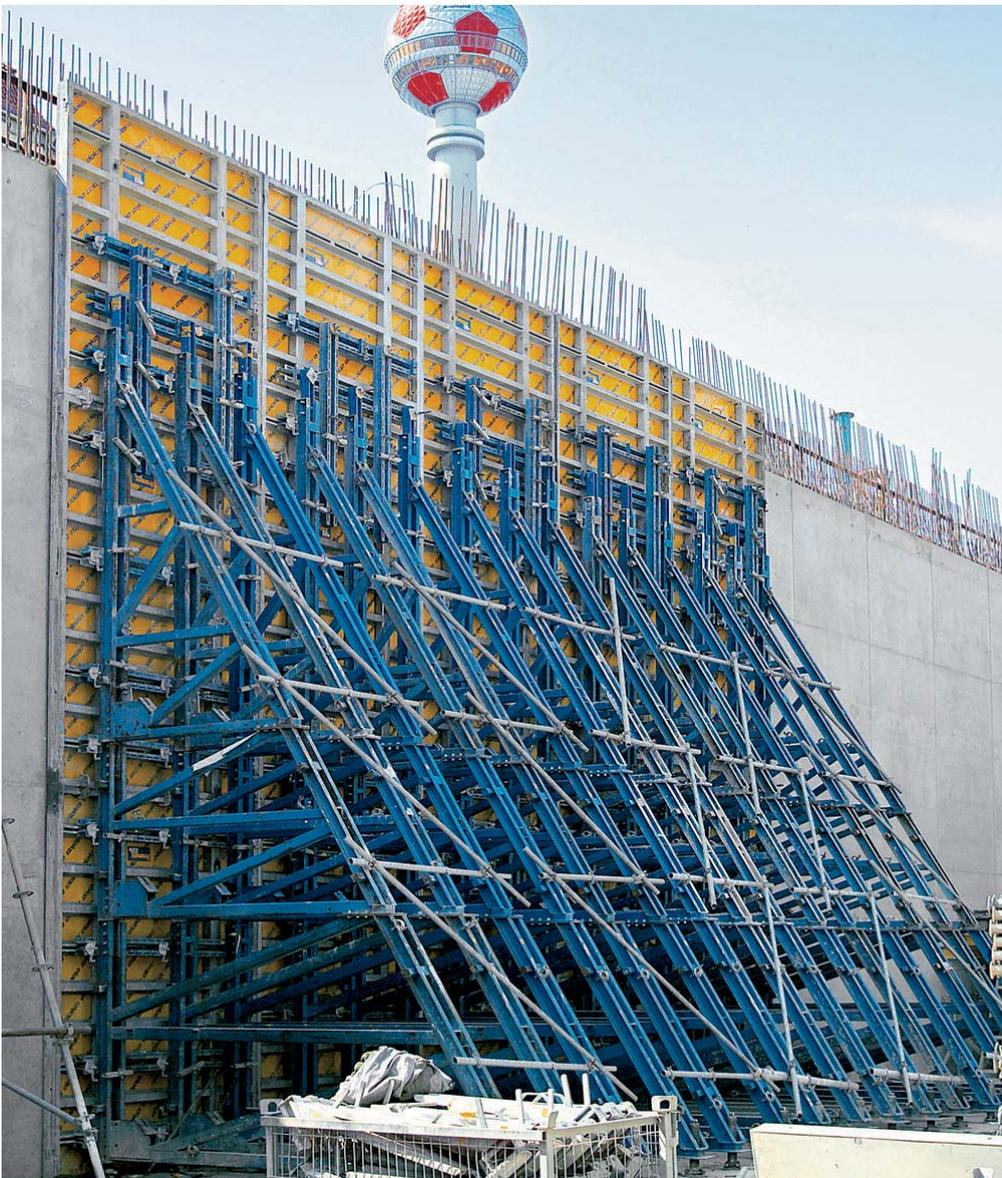
34. Moduli preassemblati di puntellazione e cassaforma pronti per il disarmo e la traslazione
