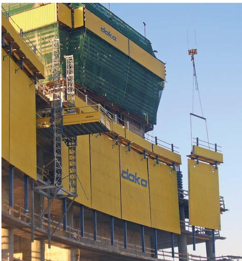
97. Schermo di protezione Xclimb 60: fase di montaggio
