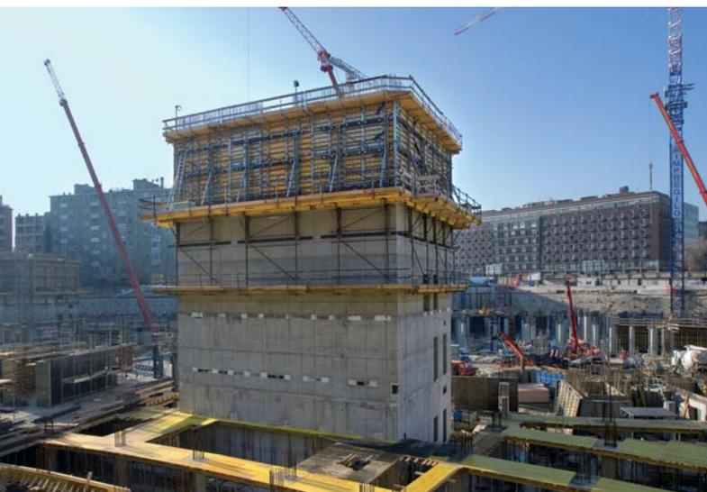
Consente l'innalzamento delle strutture verticali senza dover ricorrere ai ponteggi di protezione.
