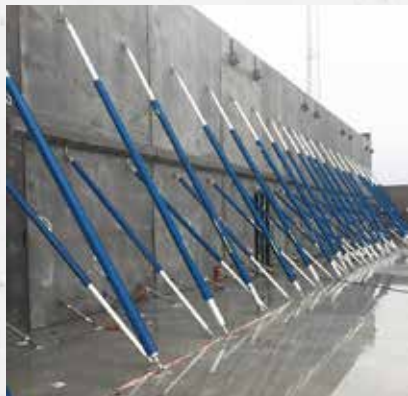
Éléments préfabriqués en béton
