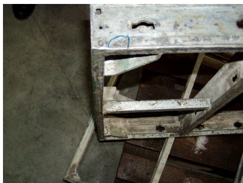
Keretprofil horpadása > 2 mm
