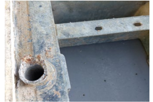
Hiányzó vagy sérült ankerhüvely
