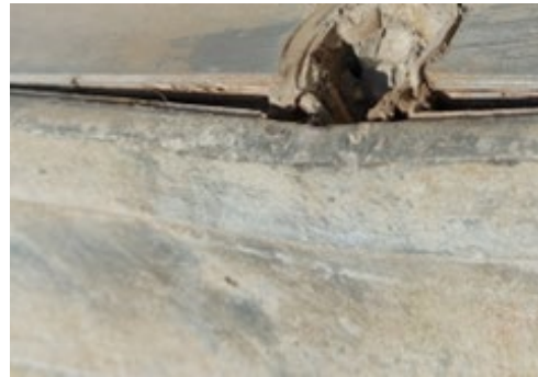
Sérült ankerlyuk és megcsavarodott hosszanti profil
