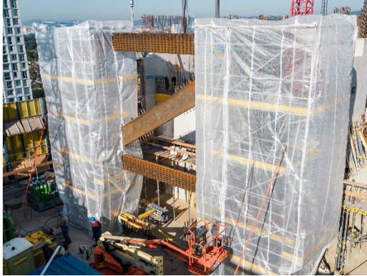
A Doka moduláris Ringlock állványzata támogatta az outrigger szerkezet körüli hegesztési munkákat. © Doka
