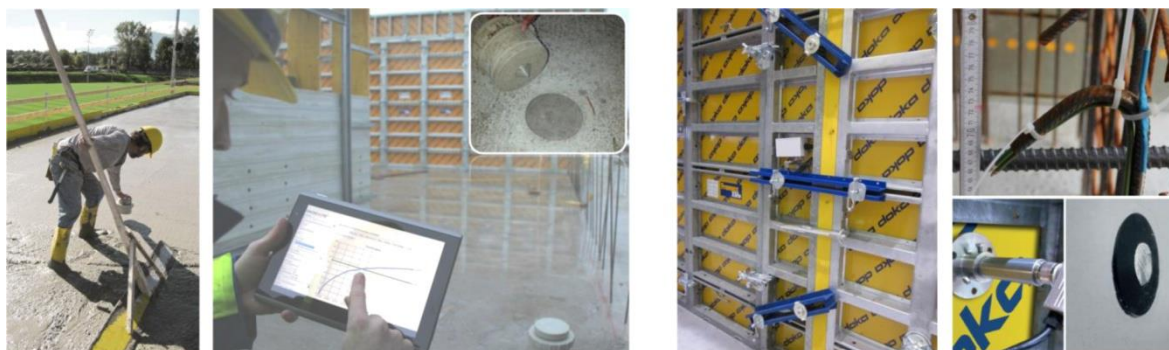
Obr. 2: Opakovane použiteľný stropný senzor umiestnený na povrchu stropnej dosky a káblový senzor v oblasti steny.
