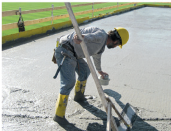
Czujnik jest instalowany w świeżym betonie po wyrównaniu jego powierzchni.
