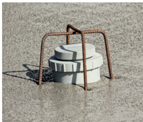
Czujniki nastropowe stosowane są po zatarciu betonu. Pomiar za pomocą czujników uruchamiany jest automatycznie.
