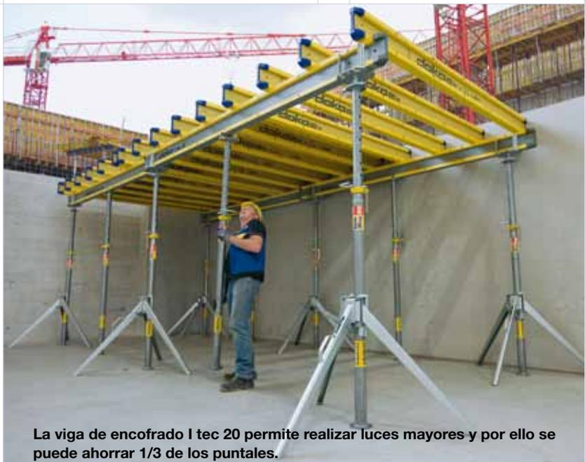
La viga de encofrado I tec 20 permite realizar luces mayores y por ello se puede ahorrar 1/3 de los puntales.
