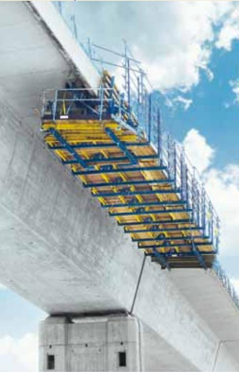
▲ El carro de encofrado TU se desplaza por la parte inferior del puente y permite hormigonar las impostas del puente incluso sin detener el tráfico.
