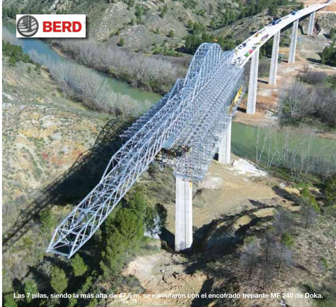
Las 7 pilas, siendo la más alta de 47,5 m, se ejecutaron con el encofrado trepante MF 240 de Doka.
