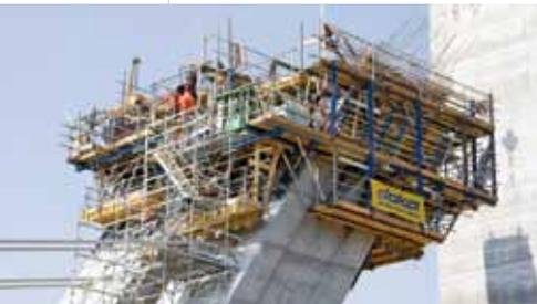
▲ 16 tongadas de 2,10 m con encofrado autotrepante SKE 50.
