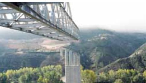
▲ La autocimbra avanza ejecutando el tablero que se desliza en curva sobre las pilas del viaducto.
