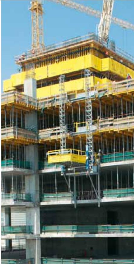
◀ Con una nueva variante autotrepante del sistema de elevación de mesas TLS ahora se pueden encofrar forjados sin utilizar la grúa aumentando además la seguridad durante el proceso de desplazamiento.
